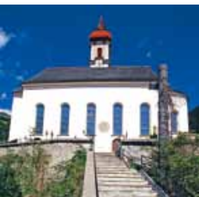
Pfarrkirche in Gossensass
